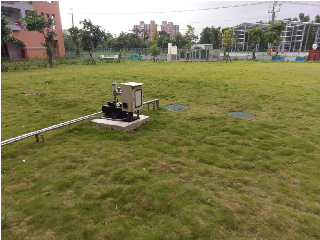
新月樓及銀河樓中間空間保留綠地，並設雨水回收系統。
