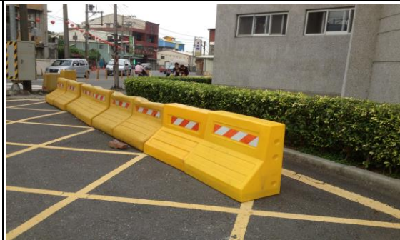
改善後： 紐澤西護欄更新。
