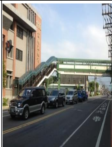
改善後： 天橋已加蓋遮雨棚
