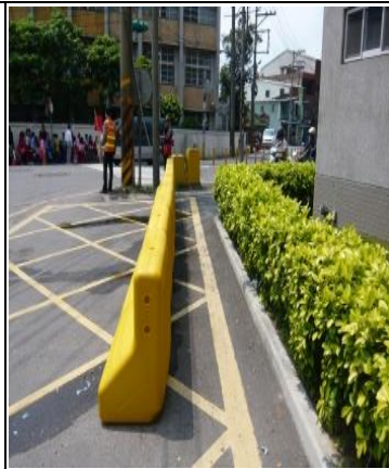
改善後： 放置紐澤西護欄建構安全通學步道
