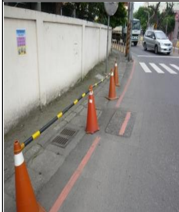
改善前： 圍牆外圍未裝設回復式安全桿
