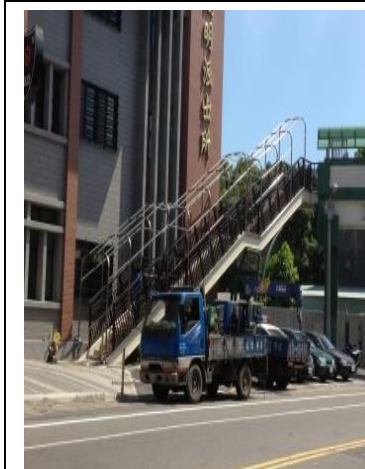
改善前： 天橋未加蓋遮雨棚
